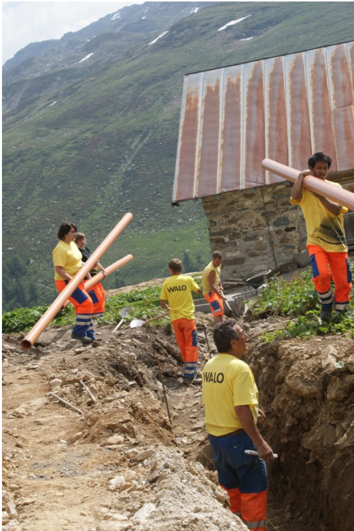
Sickerleitung verlegen... auch mit "KV-Lernenden"... (inklusive der "Stiftinnen" Messerli Martina und Bischoff Stefanie!)
