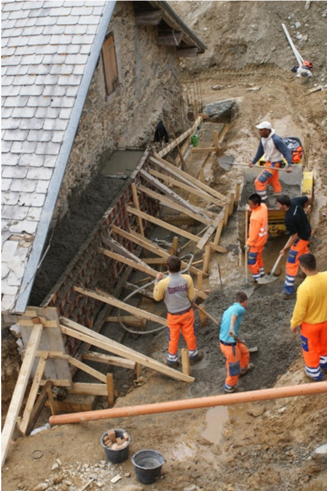
Betonieren der Stützmauer Alp Lattenstafel
