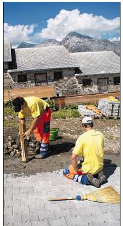
Lernende der Walo Bertschinger AG beim Verbundsteine-Versetzen. Bilder zVg
