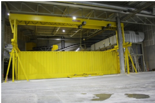
Umbauphase, Ausführung der neuen Abluftreinigungsanlage
