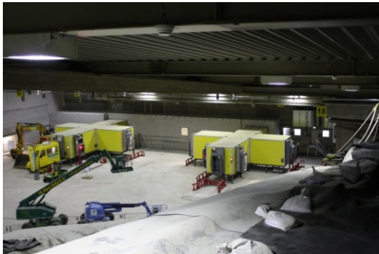
Umbauphase, Neue Dockingstation
