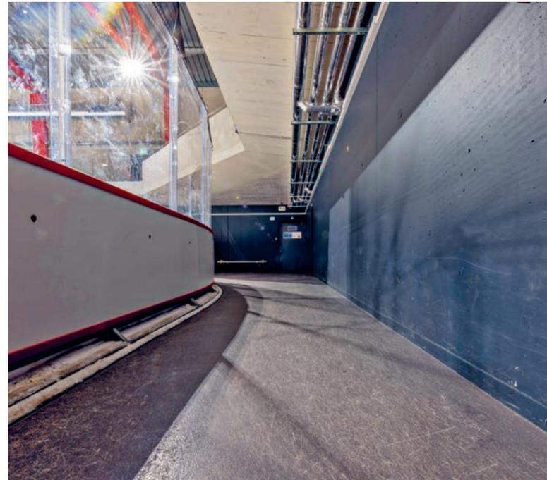
Es kamen verschiedene Beläge unserer Bodenbelagspalette zum Einsatz. Wir durften im ganzen Gebäude die schwimmenden Unterlagsböden und Zementüberzüge im Verbund einbauen. Diese dienen zu 80% als Unterlage für den einzig richtigen Bodenbelag für Kunsteisbahnen: dem HALTOPEX® Gummigranulatbelag. Im oberen Geschoss haben wir für die Sprinter auf einer 60 Meter langen Bahn einen RUB TAN® WDII erstellt.
